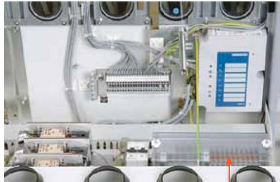
Клеммная кофодка (пломбируемая) для подключения измерительного оборудования
